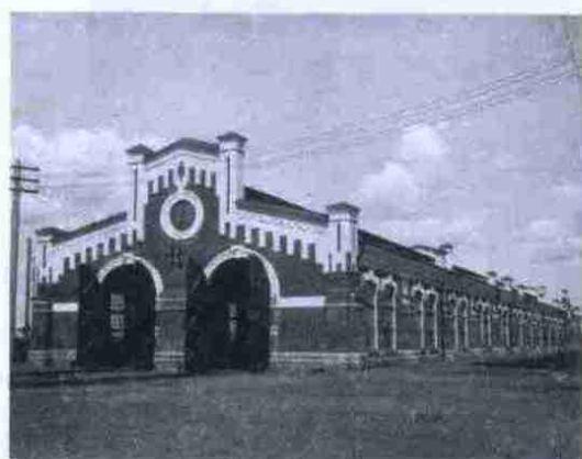
Токарно-механический цех Главных мастерских Ташкентской железной дороги. Фотография из фондов ОГАОО
