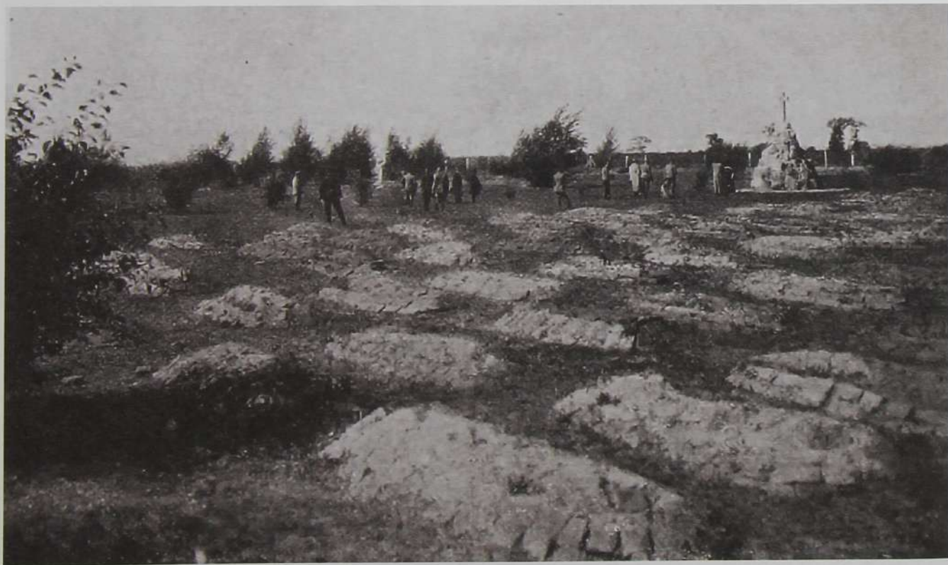
Кладбище на станции Гунчжулин. Фото 1909 г.
