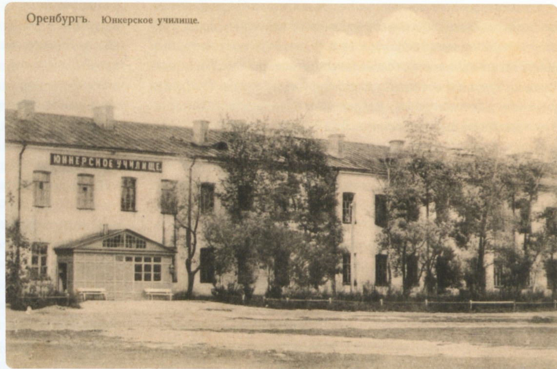
Учебный корпус юнкерского училища
