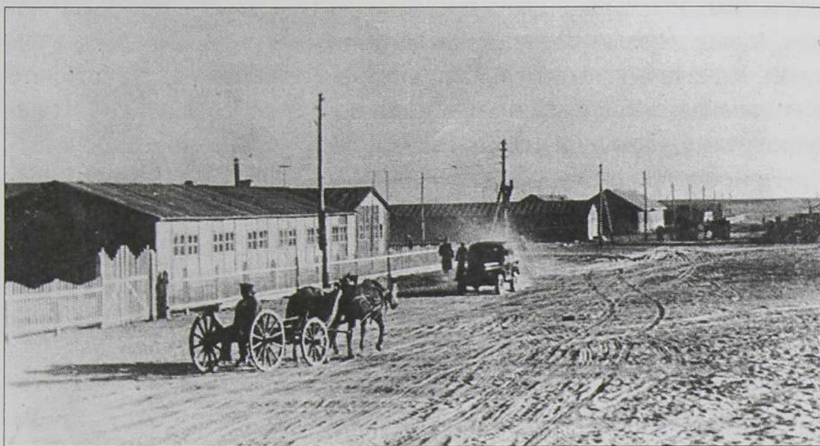
Будущий Байконур — площадка № 10. Октябрь 1956 года
