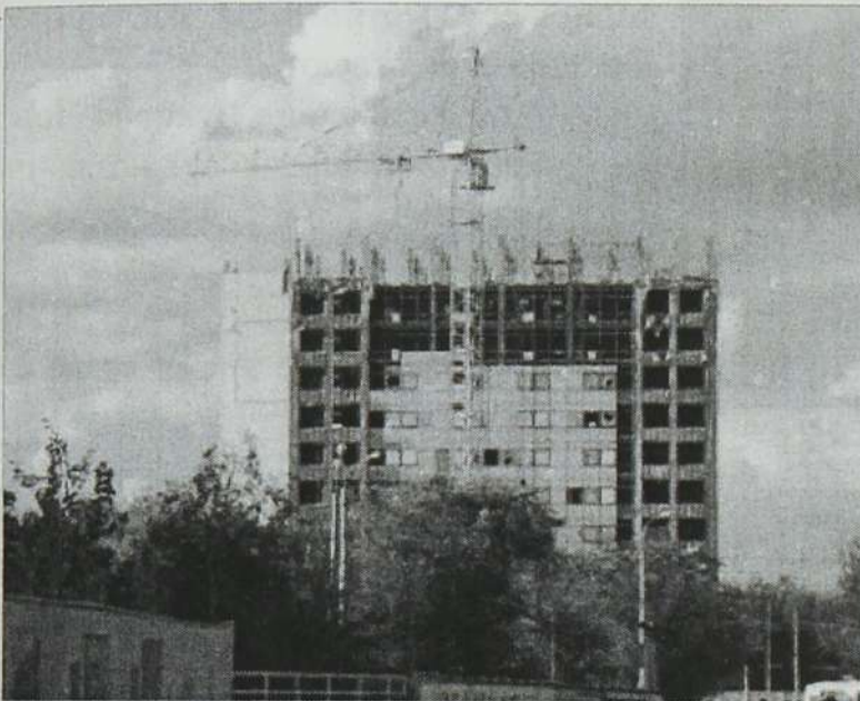
Злополучная высотка почти построена, но не устояла
