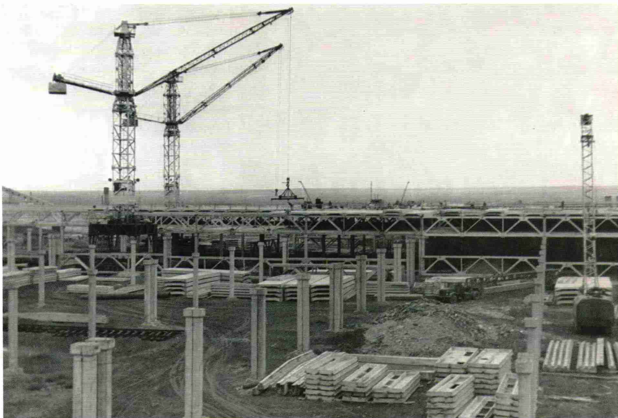
1965 год – установлены первые колонны главного корпуса прядильного производства
