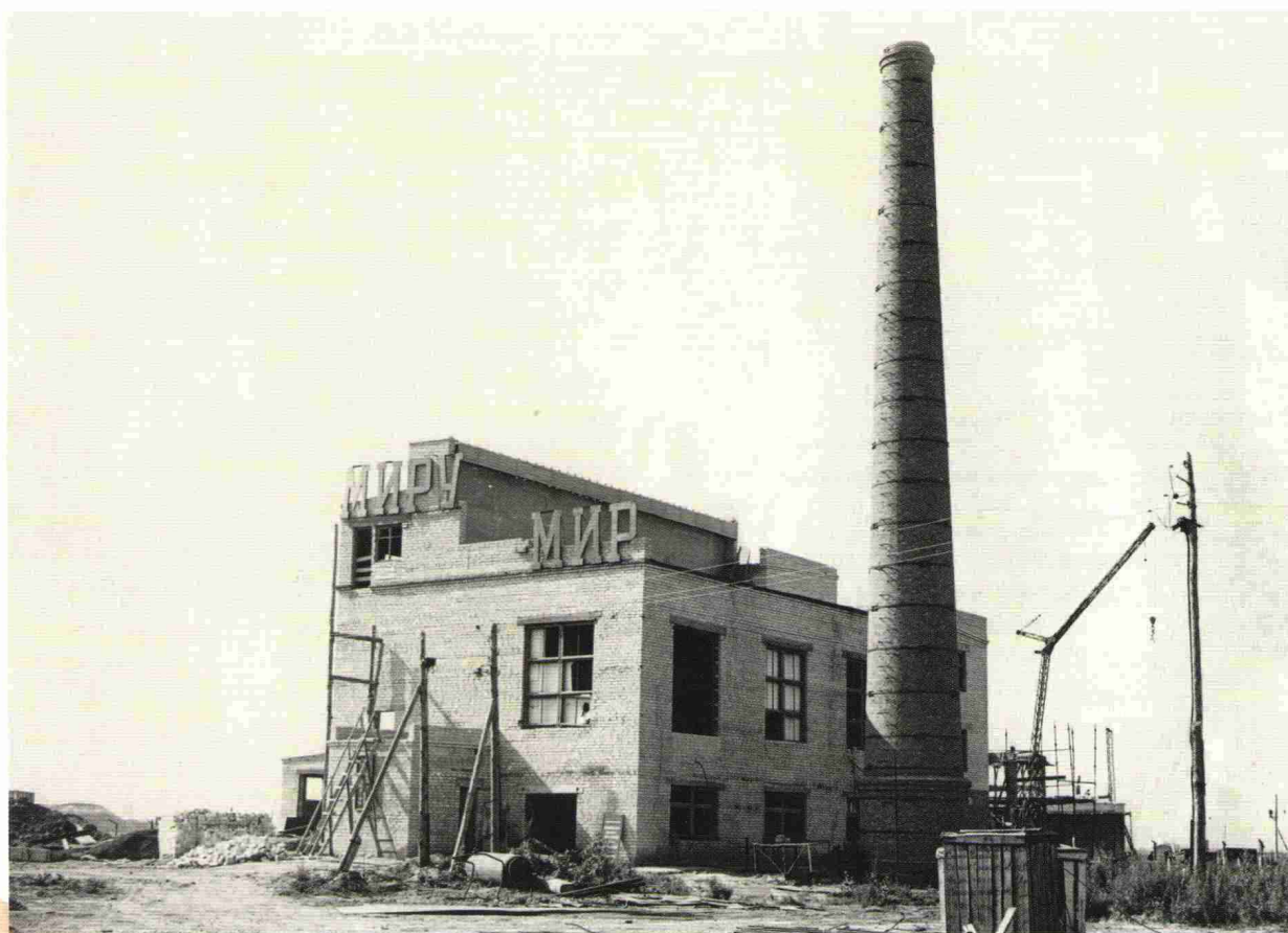
Строящийся Оренбургский комбинат шелковых тканей. Временная котельная в стадии монтажа оборудования, июль 1964 г.
