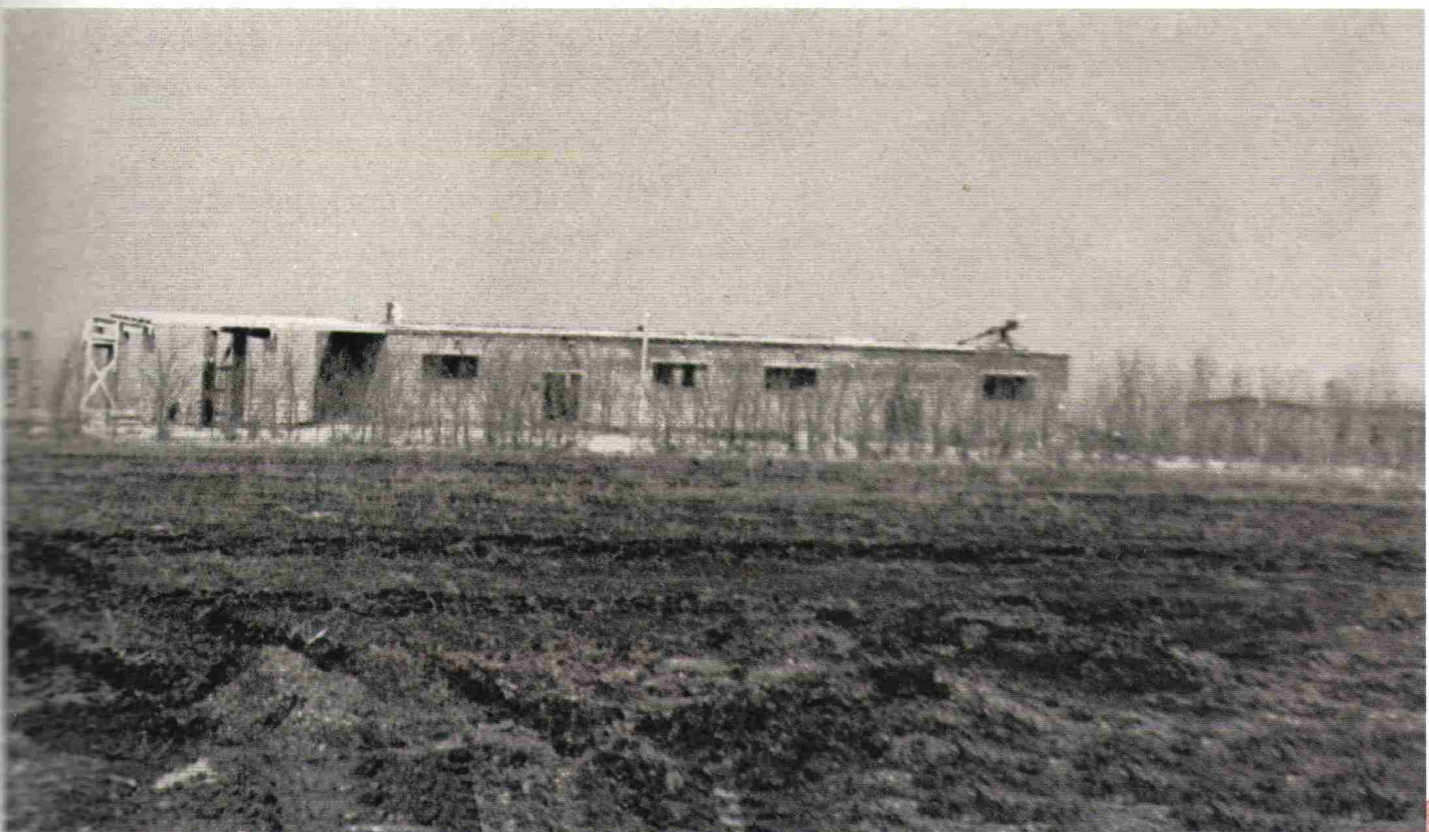
Строительство Оренбургского комбината шелковых тканей по состоянию на 1 апреля 1962 г.
