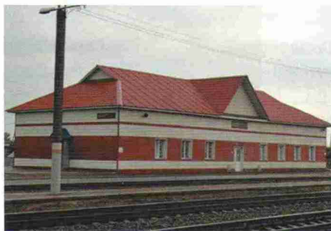
Вокзал станции Колтубанка. 2023 г.
